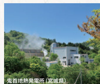
鬼首地熱発電所(宮城県)
