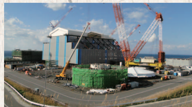
大間原子力発電所の建設状況(2012年11月)
