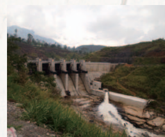
建設中のアッパーコトマレ水力発電所
