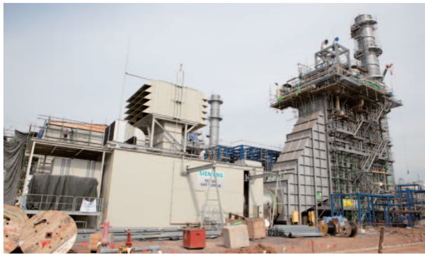
2基のガス発電機と1基の蒸気発電機の組み合わせで発電を行う。
