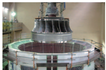
1号機水車ランナ吊り込みの様子(2011年11月)
