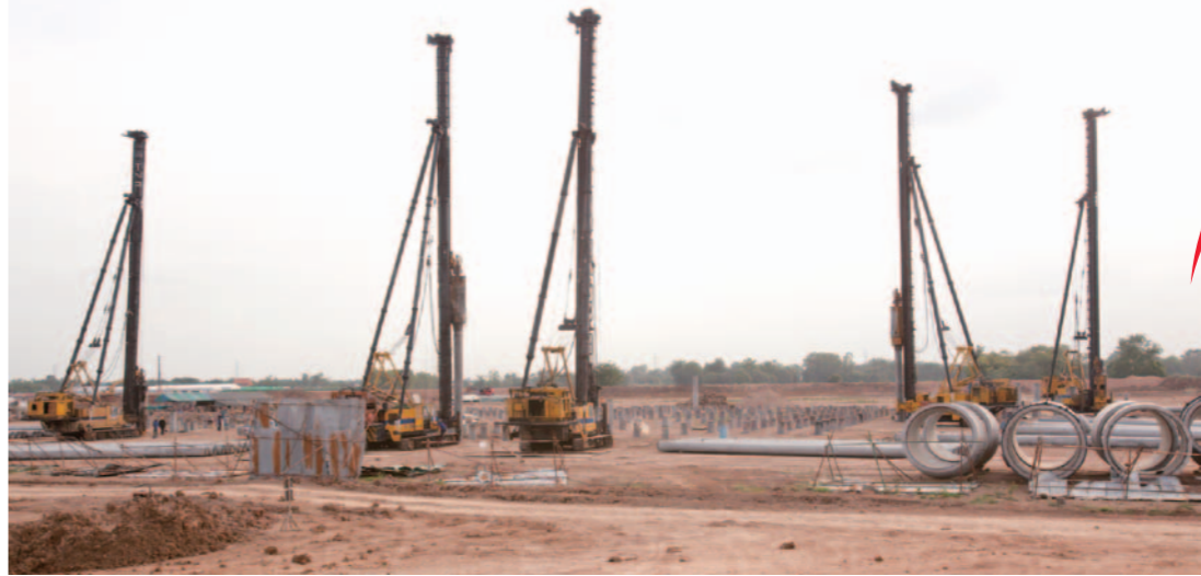
10台の杭打ち機で1日4本ずつ杭が打ち込まれている。
