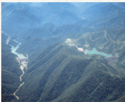
揚水式の奥清津発電所・奥清津第二発電所
