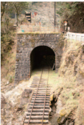
明治44年、森林鉄道開通時に建設された五味隧道。
