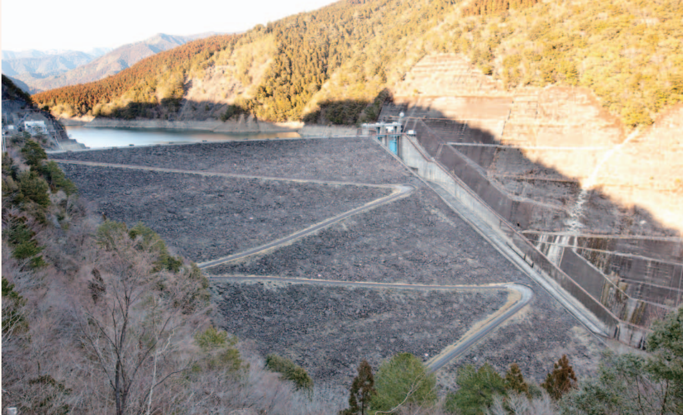
魚梁瀬ダムは、砂利や石を積み上げたロックフィルダム。同型式としては西日本最大。
