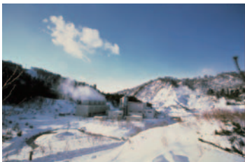
鬼首地熱発電所
