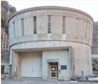
魚梁瀬発電所の建屋は円筒形が特徴。
