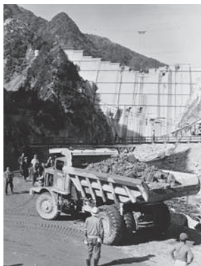
建設中の佐久間ダム・発電所
