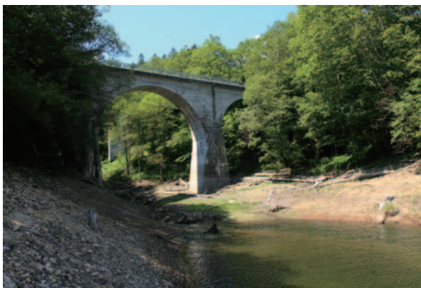
三の沢橋梁。こうしたアーチ橋梁が点在している。
