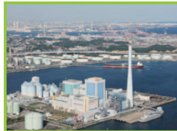
J-POWER磯子火力発電所（神奈川県）
