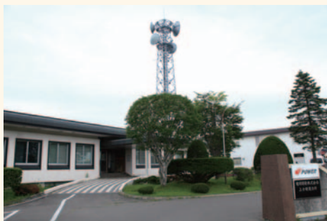
10カ所の発電施設を管理する上士幌電力所。
