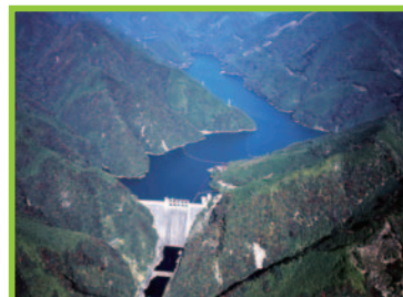
J-POWER佐久間発電所（静岡県）
