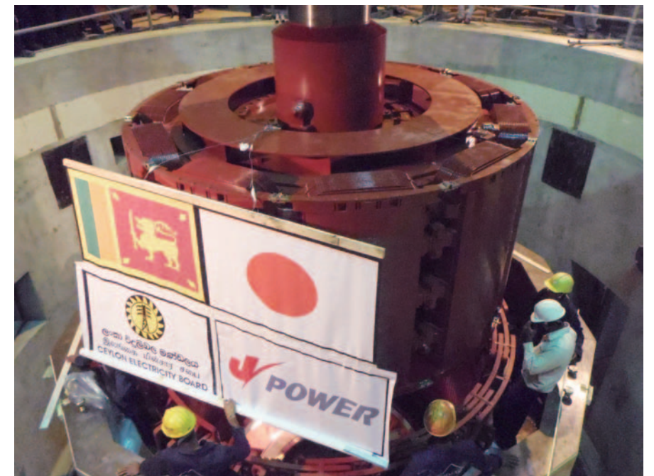
両国旗と社・庁旗を付けて吊り込まれる回転子
