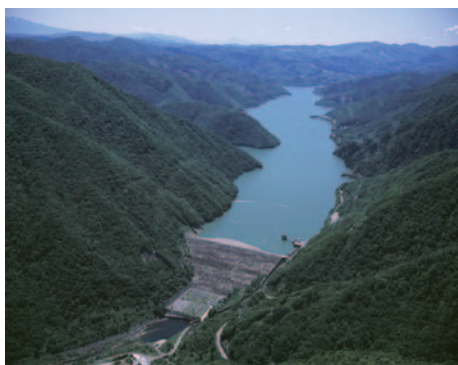
御母衣ダム▶1961年完成。岐阜県、高さ131mのロックフィルダム。最大出力は21.5万kW。
