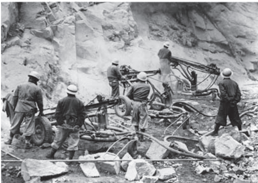
佐久間ダム建設には、日本で初めてダンプトラックやシャベルカー、ドリルジャンボ（写真左は削岩機）が使われた。
