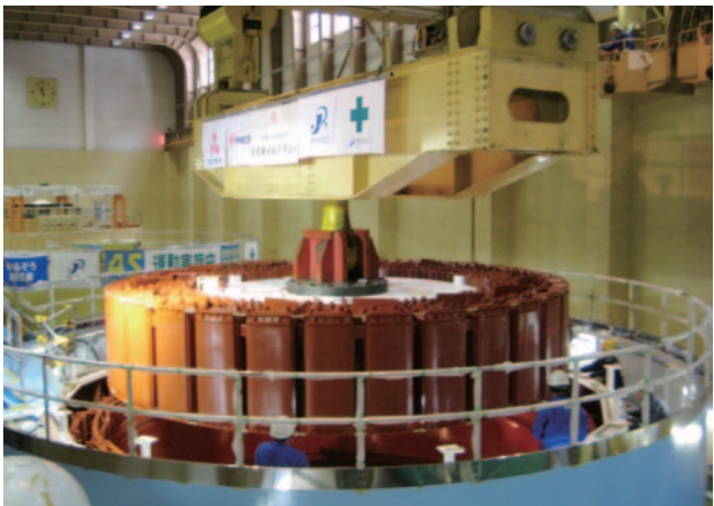
田子倉発電所では、発電機などの主要機器の更新工事が順次行われている。
