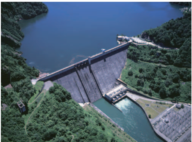
田子倉ダム・発電所(福島県)
