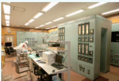
現在、常時は使われていない制御室。
