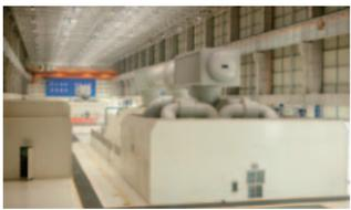
66万kWのタービンを2基設置。設備は東方電気という中国国内メーカーの製品。
