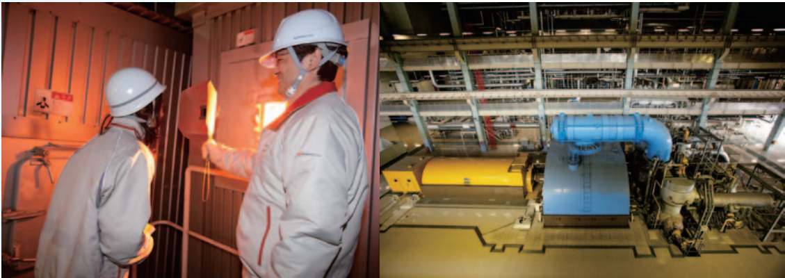
1,300度の高温で燃え上がるボイラー(左)を覗く。新1号機のタービン発電機(右)
