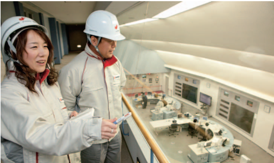
排出ガス濃度は、運転センターで24時間監視し、完全に制御されている。
