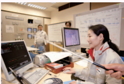
制御盤を実際に操作する筆者。
