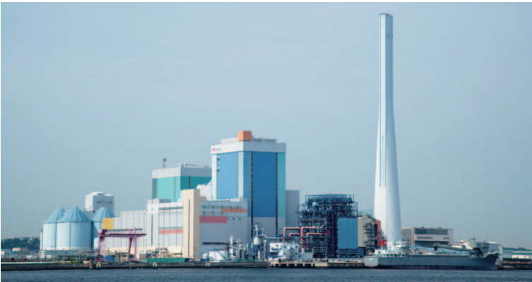
磯子火力発電所
