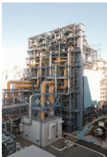
乾式排煙脱硫装置は、水を必要とせず、コンパクトに設置できる。
