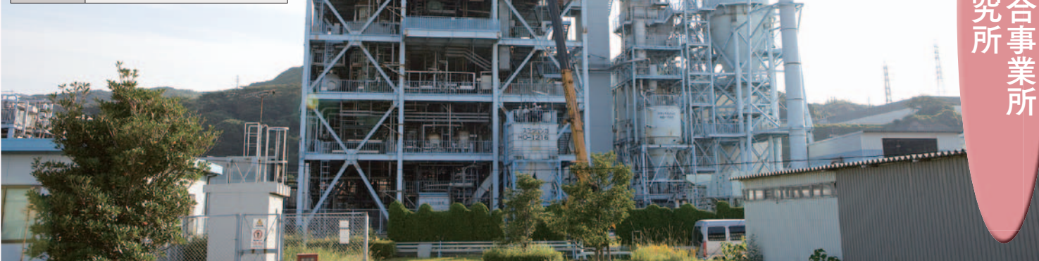
発電効率を高め、CO 2 の分離回収もできるEAGLEの試験設備。
