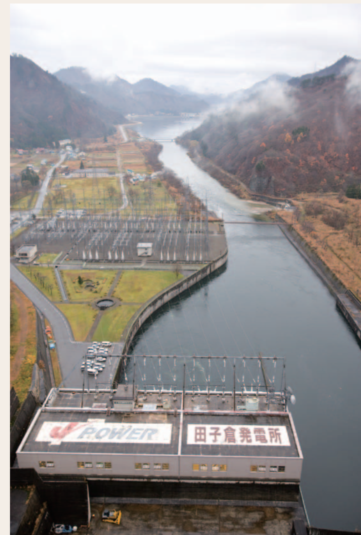
田子倉ダムの堤頂から下流を見る。奥に見えるのが只見ダム。
