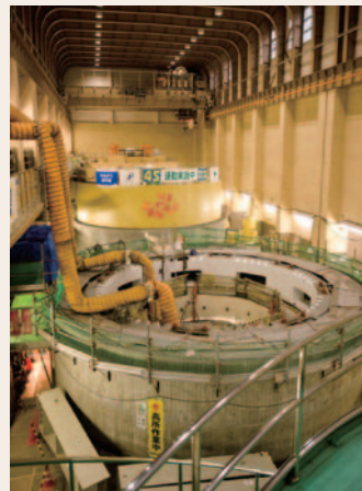
現在工事中の3号機。
