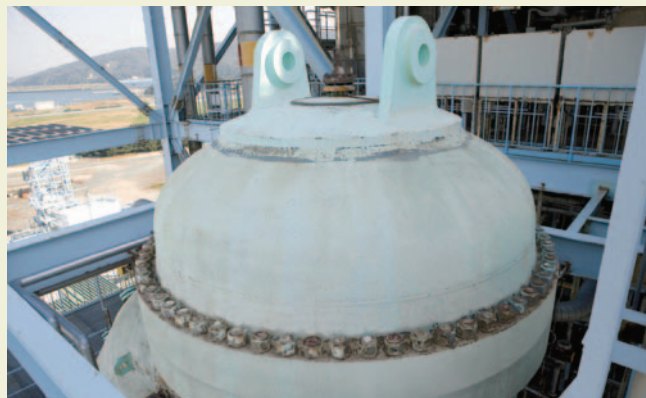
石炭ガス化炉压力容器上部。
