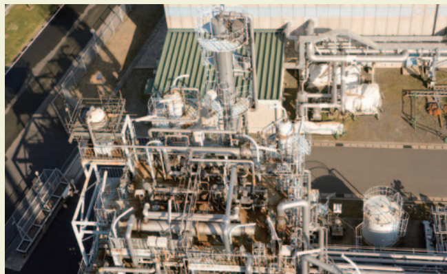
湿式化学吸収法により脱硫を行う。
