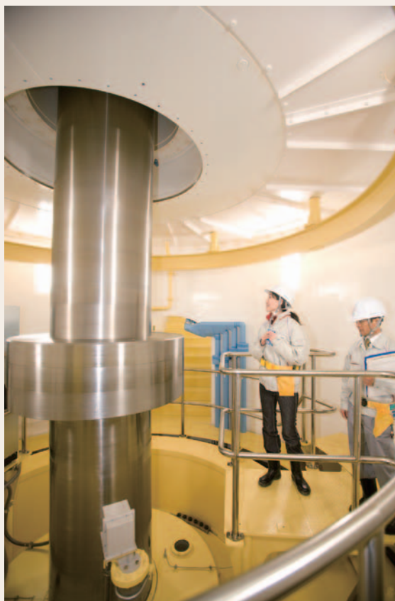
更新された4号機では水車が高速で回転していた。
