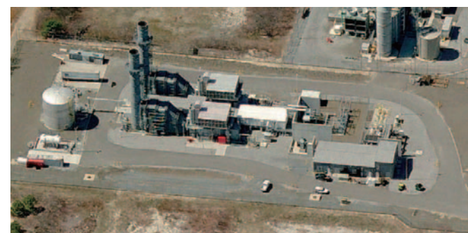
エッジウッド発電所
