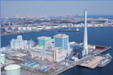
磯子火力発電所
