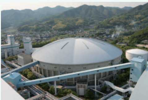
3号機の貯炭場。
