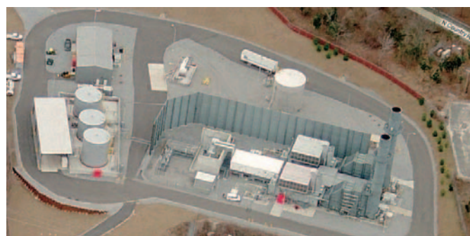
ショーハム発電所
