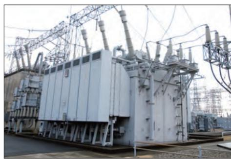
変電所のメインとなる主要変圧器。275kVの電圧を154kVに下げて送電する。
