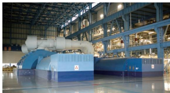
発電所の心臓部。105万kWのタービン・発電機。
