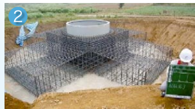
コンクリートを打設するための配筋を行う
