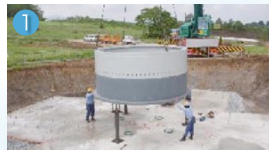
穴を掘り、基礎金物を据え付ける
