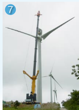
ブレード（翼）を据え付けて完成
