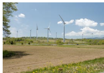
農業との共生 畑の中にあるため、油を使用しない発電機が採用された
