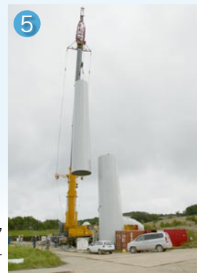
上層部のタワーも据え付ける
