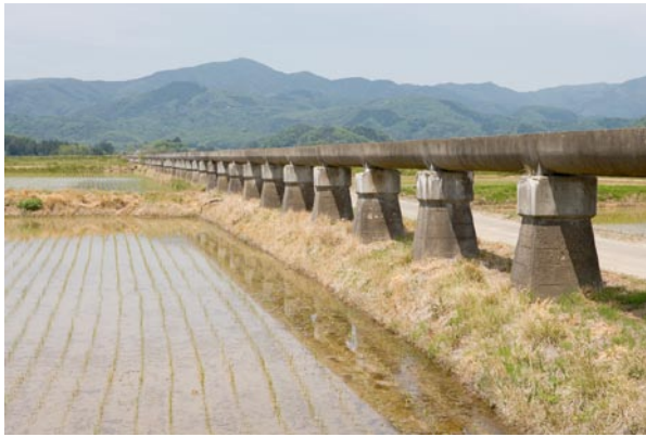
高台の田にも水を引くためのサイホン式水路が続いている。
