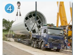
下層部のタワーを吊り上げる
