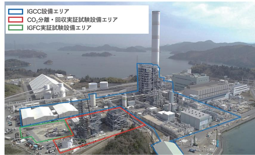
実証試験設備配置図(中国電力(株)大崎発電所構内)
