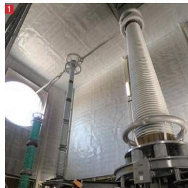
1 ケーブルヘッドの建屋内部。大きな空間や円形窓で高圧送電線から十分な隔離を保っている。 2 海底ケーブル内の導体は絶縁油で覆う必要があり、その最適量を保つための給油装置の稼働状況に目を光らす。 3 海底ケーブルと地中ケーブルのジョイントの信頼性を高める工事に向けマンホール拡幅工事を進める。 4 ケーブル内の絶縁油などは常時監視されており、警報発生時には即座の故障対応が取られる。 5 専門性の高い少数精鋭のスタッフの連携が重要だ。
