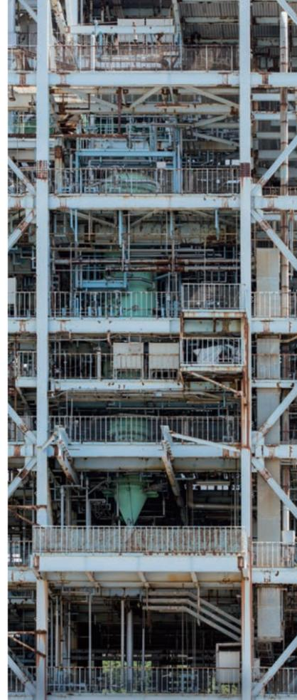
中央に見える縦長の筒状のものが石炭ガス化複合発電（IGCC）の石炭ガス化炉圧力容器。
