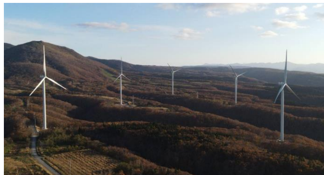
Esashi Wind Farm
