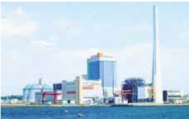
Isogo Thermal Power Station (Kanagawa Prefecture)
