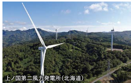
上ノ国第二風力発電所(建設当時)
