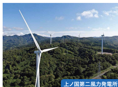
上ノ国第二風力発電所
