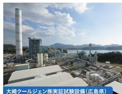
大崎クールジェン(株)実証試験設備(広島県)
