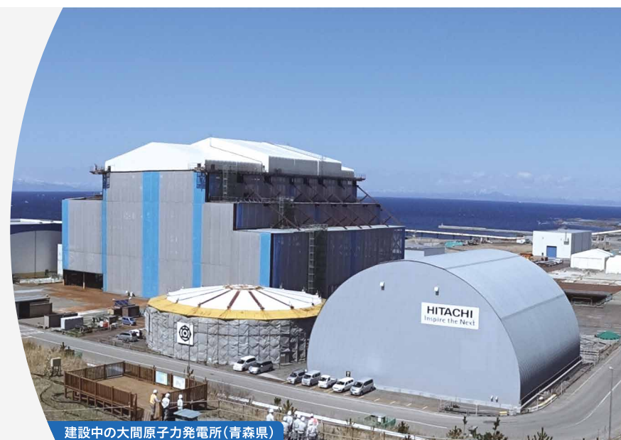
建設中の大間原子力発電所(青森県)
