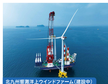
北九州響灘洋上ウインドファーム(建設中)
