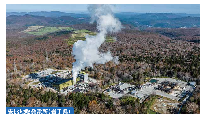
安比地熱発電所(岩手県)
