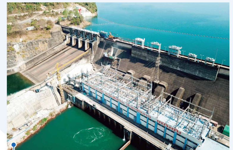
ナムグム第一水力発電所(ラオス)
