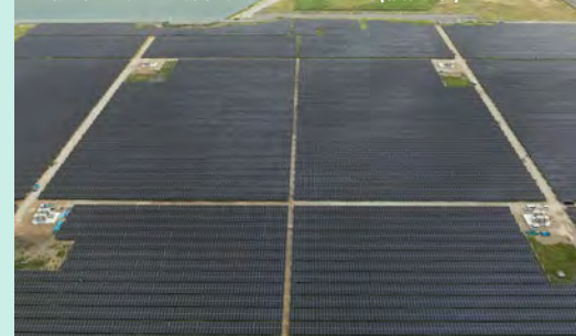
建設中の北九州響灘太陽光発電所(福岡県)
