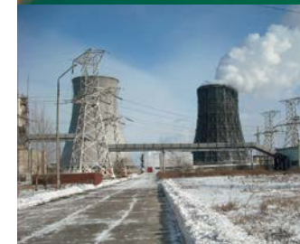
ウランバートル第4発電所(モンゴル)
