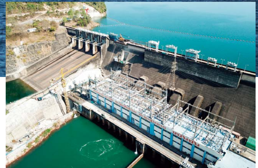
ナムグム第一水力発電所(ラオス)
