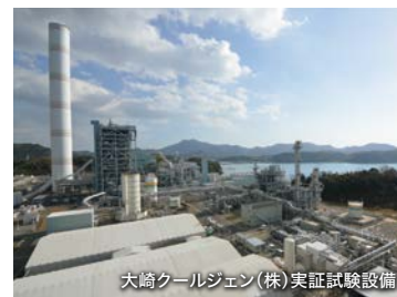
大崎クールジェン(株)実証試験設備
