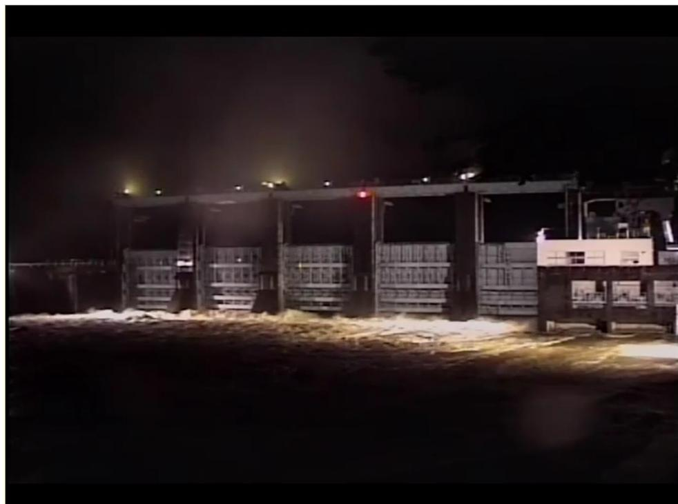
瀬戸石ダム通砂／排砂運用中状況(2019年7月14日00時00分、3,200m<sup>3</sup>/秒 放流状況)
