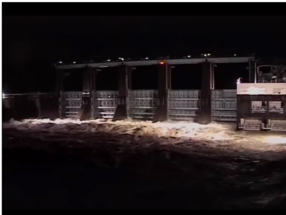
瀬戸石ダム通砂／排砂運用中状況(2019年7月3日21時30分、2,085m 3 /秒 放流状況)
