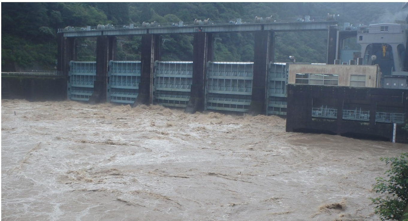
瀬戸石ダム通砂／排砂運用中状況(2018年7月7日12時20分、3,880m 3 /秒 放流状況)
