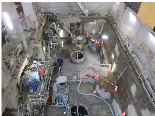
写真② 水車発電機基礎取壊しの様子
