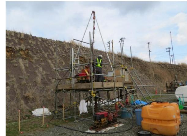
図2 ボーリング調査作業状況(事例)
