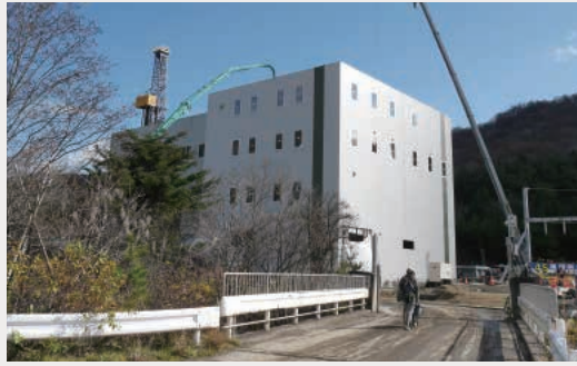
建設中の発電所本館。奥に見えるのは還元井
