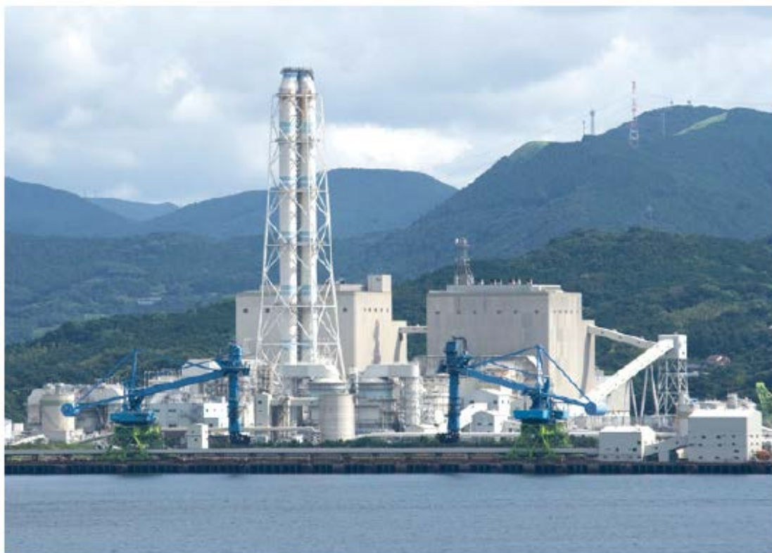
バイオマス燃料である木質チップなどを活用する松浦火力発電所(長崎県)
