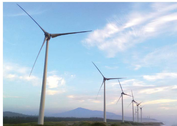
由利本荘海岸風力発電所
