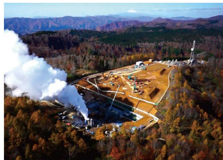
建設中の山葵沢地熱発電所
