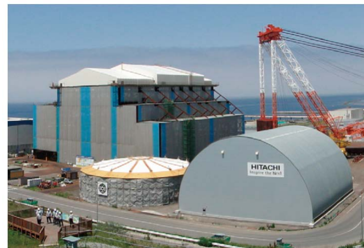
建設中の大間原子力発電所
