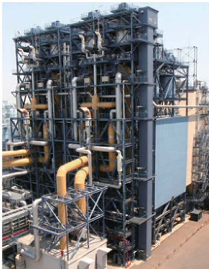
乾式脱硫装置（磯子火力発電所新2号機）
