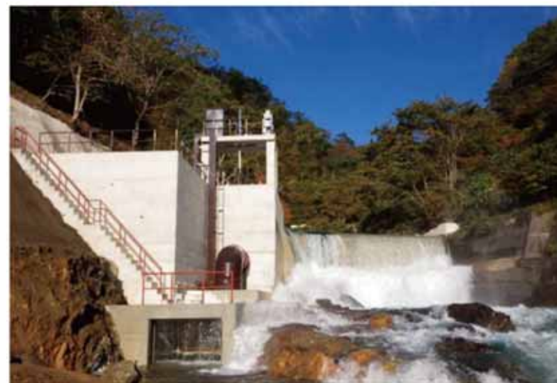
このき谷発電所
