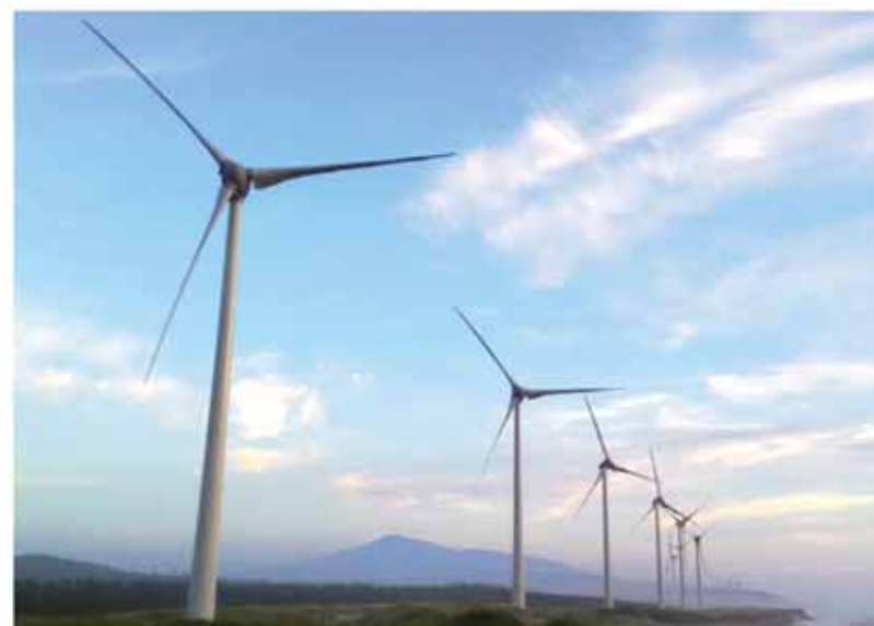
由利本荘海岸風力発電所
