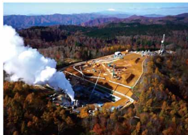
建設中の山葵沢地熱発電所
