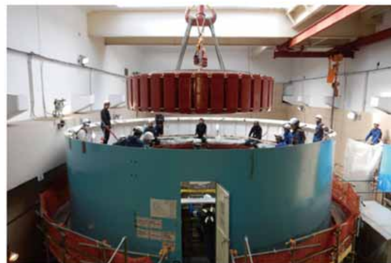
秋葉第一発電所 2号機回転子吊りこみ
