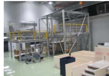
事務所棟 訓練施設
