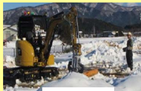
無線重機訓練
