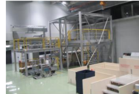
事務所棟 訓練施設
