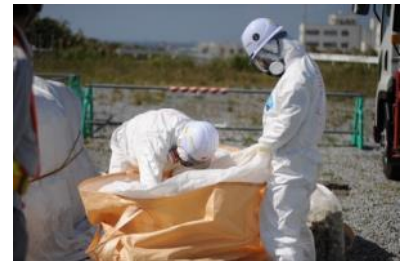
モバイル訓練: 放射性物質吸着材設置
