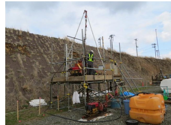
図2 ボーリング調査作業状況(事例)
