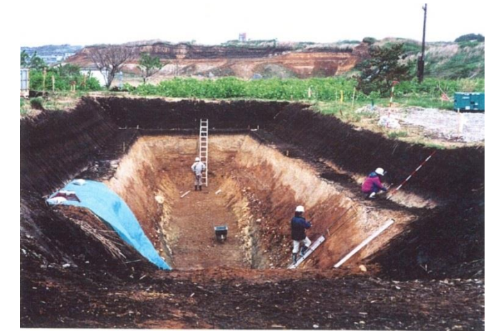
図3 トレンチ調査作業状況(事例)
