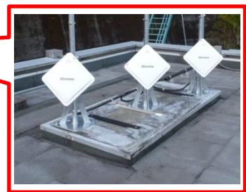
衛星電話のアンテナ設置状況 (北山川電力所ダム制御所)
