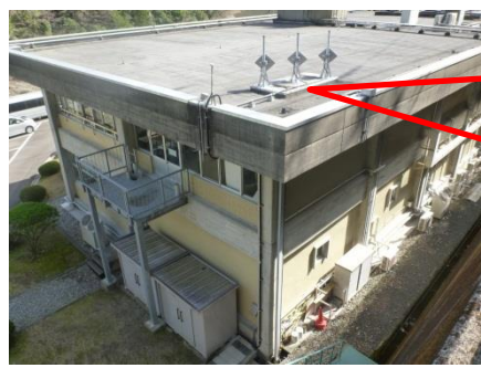
衛星電話のアンテナ設置状況 (北山川電力所ダム制御所)
