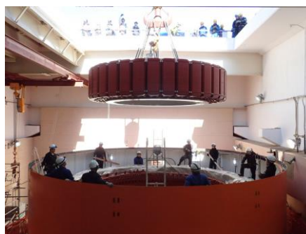
回転子吊り込みの様子（平成 30 年 2 月）
