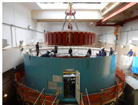
回転子吊り込みの様子（平成 29 年 3 月）
