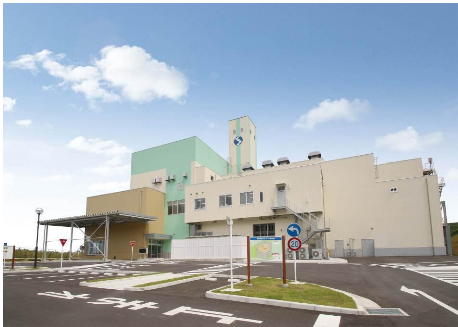
（施設外観：西海市炭化センター）
