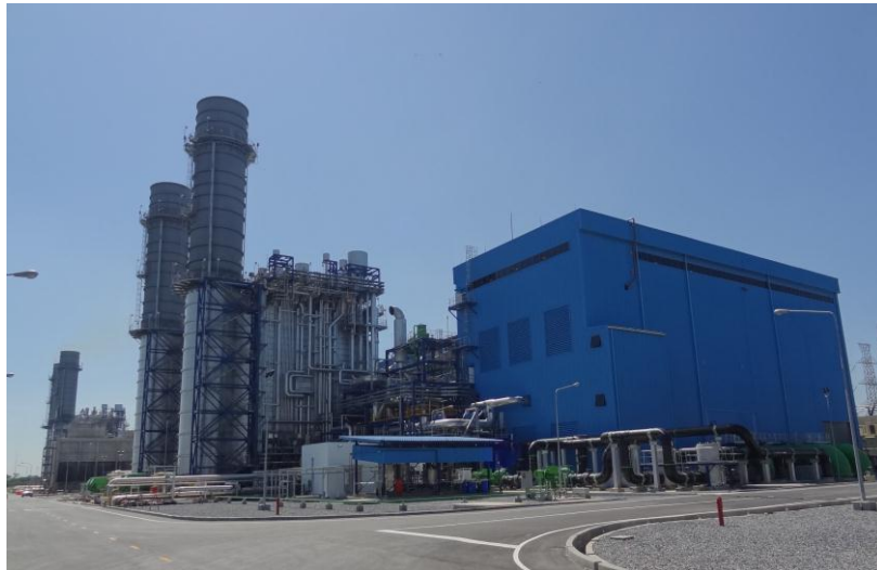
(写真手前：2 号系列、写真左奥：1 号系列)
