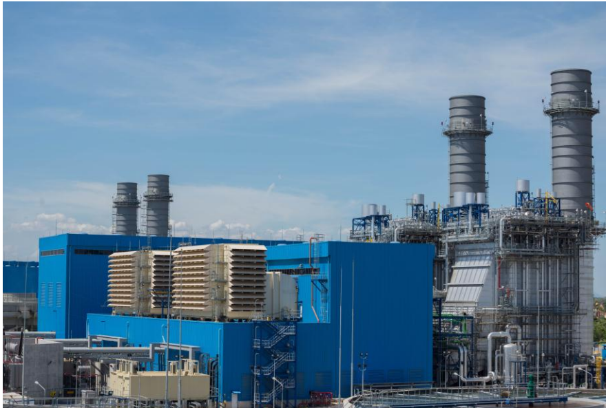
(写真手前：1号系列、写真左奥：2号系列)
