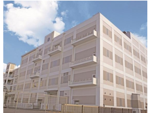
燃料化施設外観
