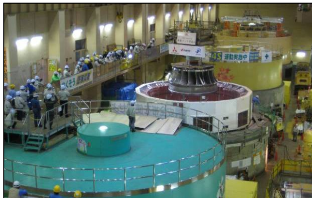
3 号機水車ランナ吊込みの様子（平成 21 年 12 月）
