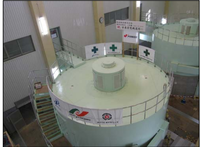
一括更新工事が竣工した糠平発電所 1 号機
