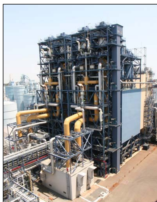
ReACT（Jパワー磯子火力発電所新2号機）
