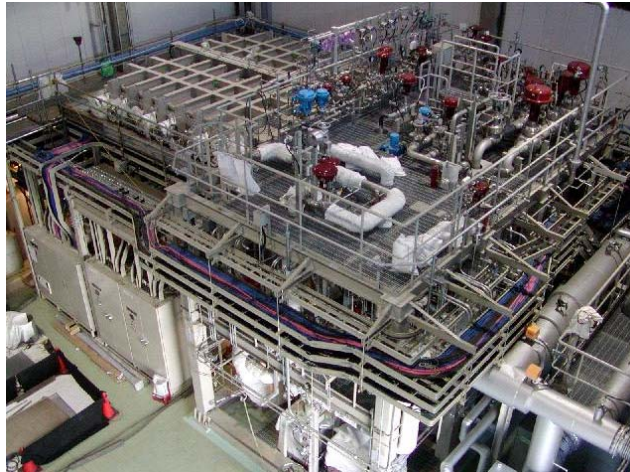
常圧 150 kW 級 SOFC システムの外観
