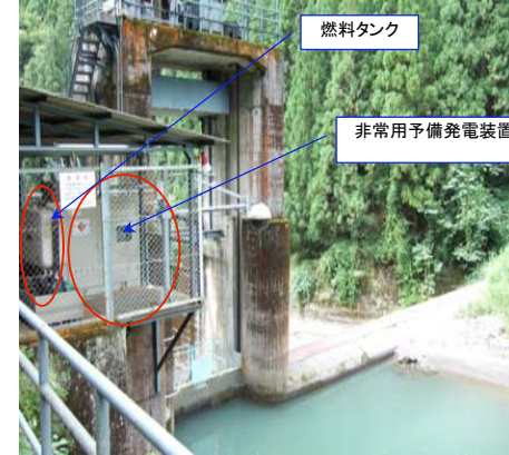
有本取水ダム 非常用予備発電装置(左)及び燃料タンク(右)
