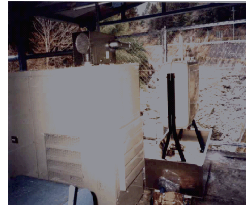
有本取水ダム 非常用予備発電装置(左)及び燃料タンク(右)
