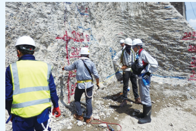
施工状況検査の様子
