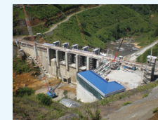
アップーコトマレダム建設の様子
