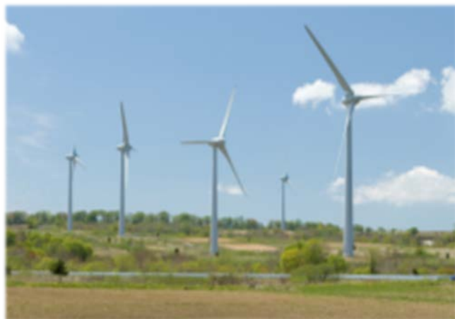
[郡山布引高原発電所]
