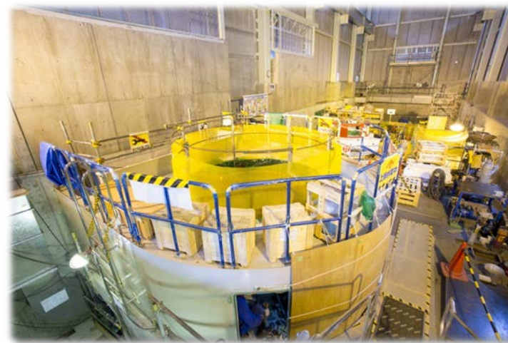
[胆沢第一発電所建設工事*]
