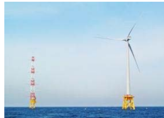
洋上風力発電システム実証研究
