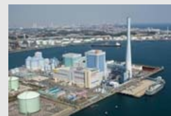
世界最高の熱効率と環境性能を誇る礮子火力発電所
