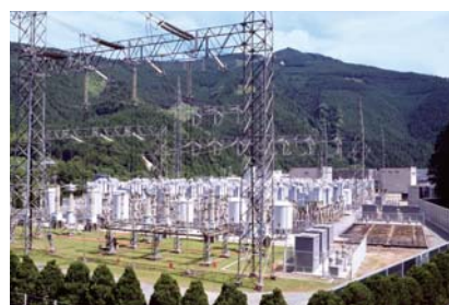
佐久間周波数変電所
