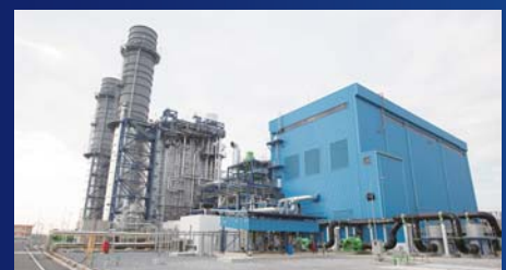
ウタイガス火力発電所 (タイ)
