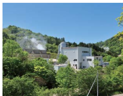
鬼首地熱発電所(宮城県)
