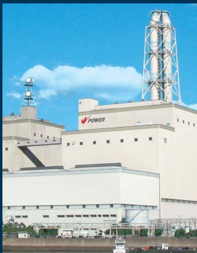
松浦火力発電所(長崎県)
