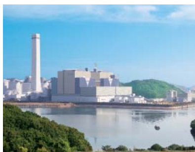
橘湾火力発電所(徳島県)
