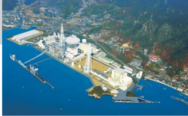
竹原火力発電所(リプレース後)
