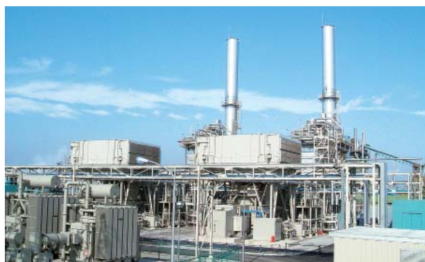
ベイサイドエナジー市原発電所(千葉県)
