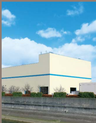
広島市西部水資源再生センター 燃料化施設(広島県)
