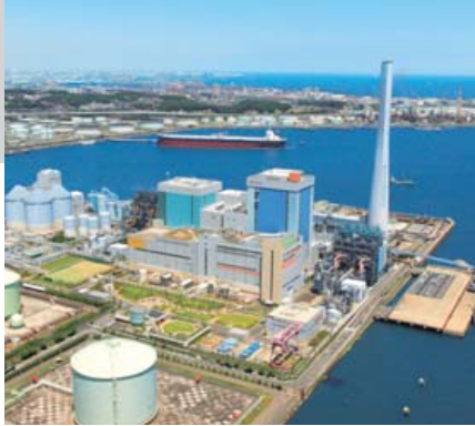
礪子火力発電所(リプレース後)
