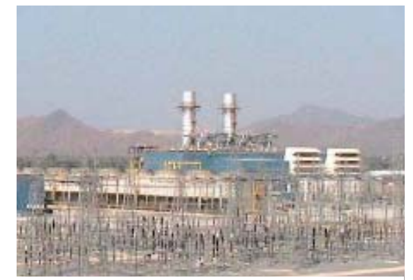
20年3月に運転開始した タイ国カエンコイ2ガス火力2号機
