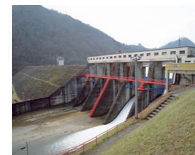
旧胆沢第一発電所と共に歴史を刻んだ石淵ダム
