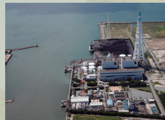
写真：橋湾火力発電所(徳島県阿南市)
